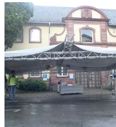
Die neue Kulturbühne der Stadt wird aufgebaut. Stifter sind die Stadtwerke.
